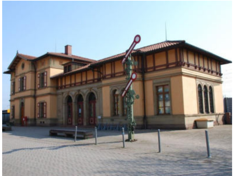
Alter Bahnhof von Neudorf
