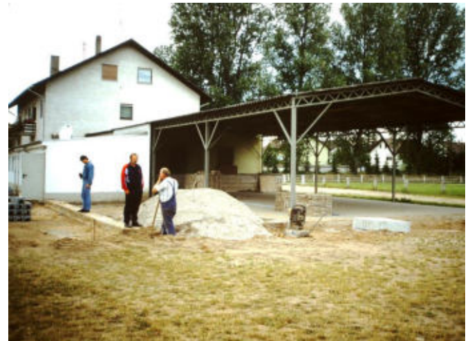
1990 Ausbau Festhalle Das Fundament für die Sportfestküche wird gegraben
