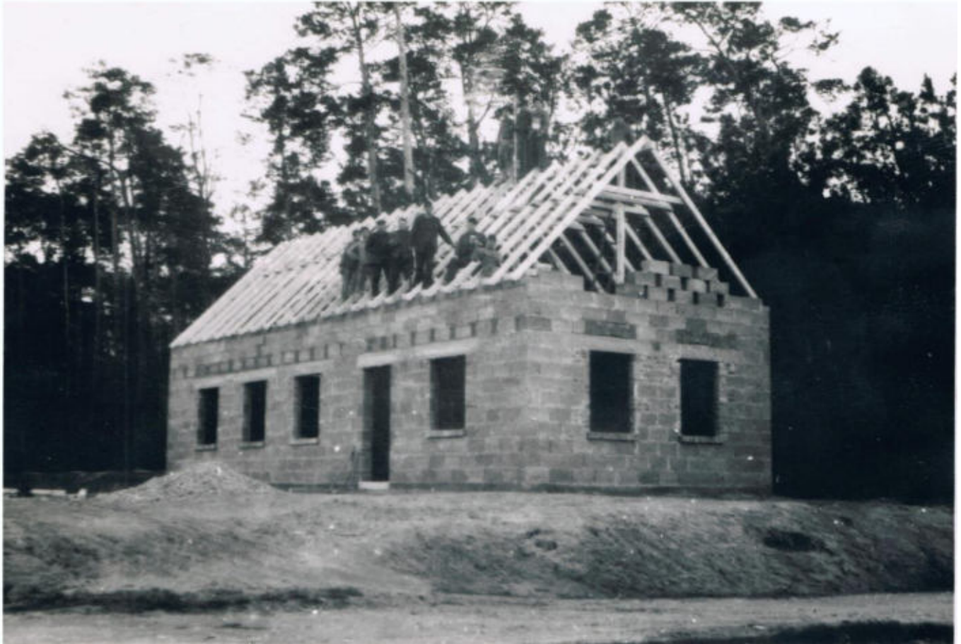
Rohbau und Richtfest des ersten Clubhauses der FVgg Neudorf im Jahre 1949
